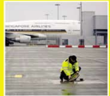
Manhole frame bedding
